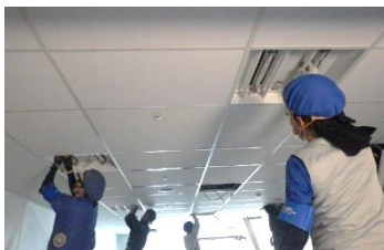
LED照明器具交換作業の様子
